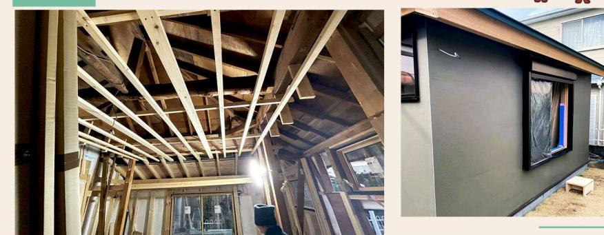
松戸市で増築工事中O様邸では和室をスケルトンにして増築。大量の荷物をストックできるように、収納充実の洋室として造り変えをしています。サッシなどの入れ替えもして、断熱性にもこだわっています！
