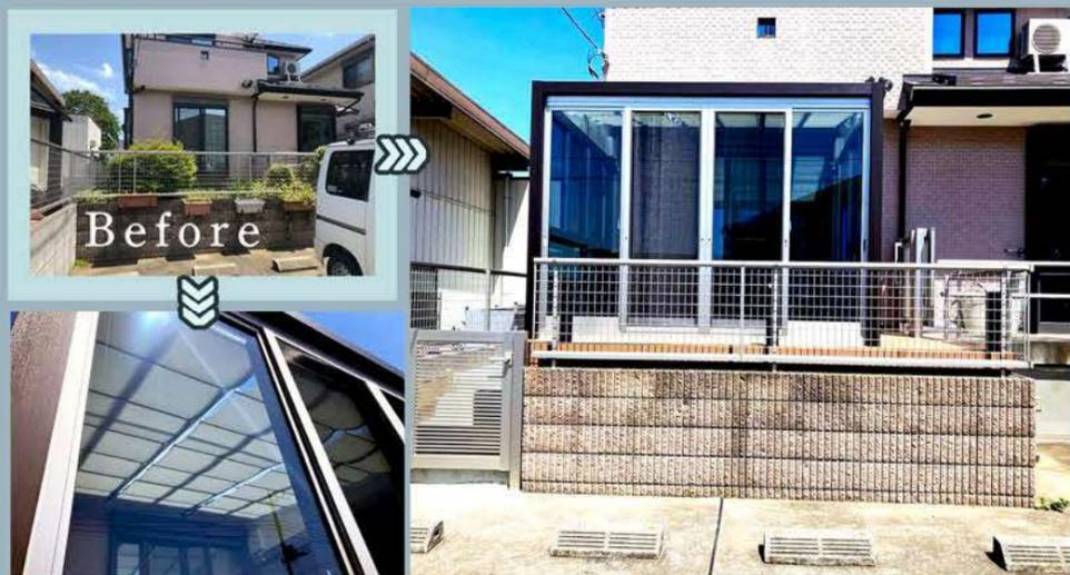
あまり使い道がなく、雑草の処理に悩まされていたお庭にガーデンルームを設置しました! 四季や天候に左右されず、太陽の光を楽しむことができる快適なお部屋です。ガラス面が多い分、日差しや暑さを制御できるよう遮光カーテンを取付け換気扇を設置し、空気の循環と通気性を確保。窓ガラスには遮光と遮蔽を兼ねたガラスフィルムを貼ることでプライバシーと快適性も確保できました。ガーデンルームの周りに人工木のウッドデッキを施工することで高低差を解消し、バリアフリーに。駐車場から直接アプローチできるように、既存ブロック塀を一部解体し階段と門扉を取付けました。これまでは、むしってもむしっても生えてくる雑草、使い方がよくわからなかった無駄なスペース、と悩まれていましたが、四季折々太陽の恵みを楽しめる素敵な空間となりました。
