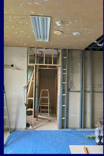
施工中の様子
