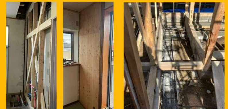
筋交い補強 構造用合板補強 基礎補強の様子の写真です
